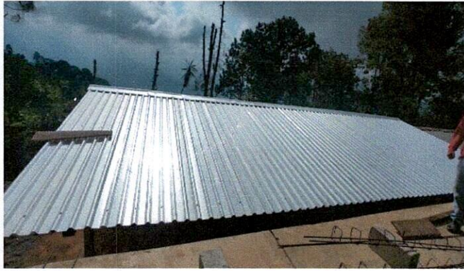
Foto 1: CUBIERTA DE LAMINA
