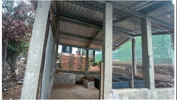
Foto 2: REPARACION DEL AREA DE COCINA
